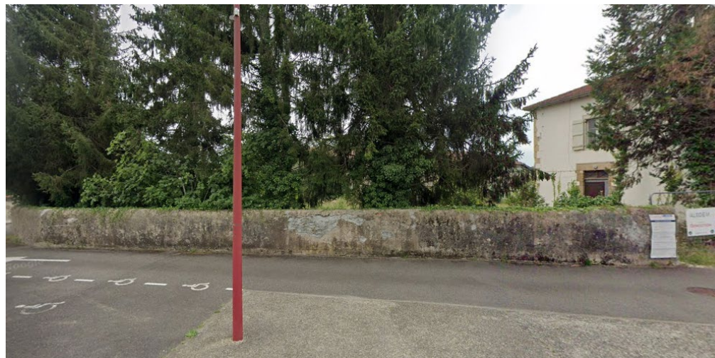
Le muret en l'état
